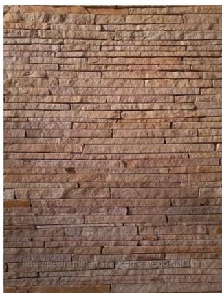
Após a cura completa do chapisco e emboço (cerca de 10 dias), iniciar-se-á a colocação das pedras, com argamassa de alta adesividade, na proporção 1:3 de água e argamassa, o que dispensa a operação de molhar as superfícies do emboço e da pedra.
